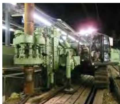
軌道内施工、機械式継手
