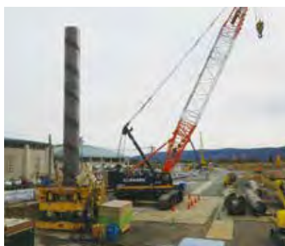
全周回転機による施工
