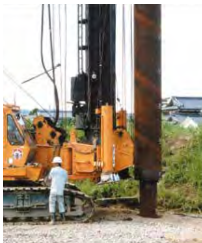
拡頭杭の施工
