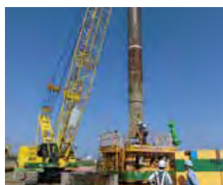
ヤットコ挿入状況
