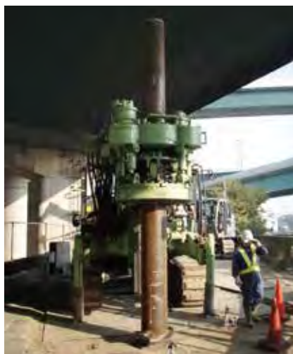
低空頭・狭隘地施工
